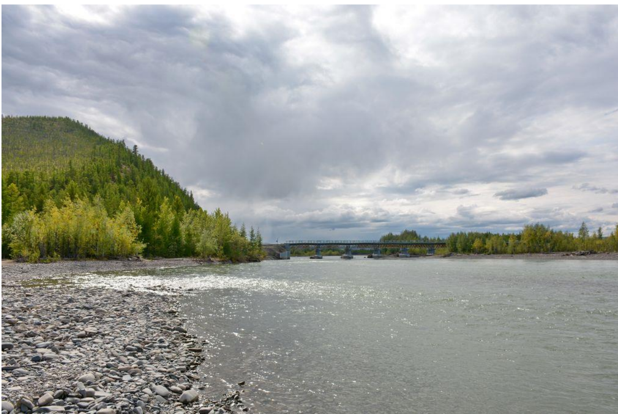
Фото 184, мост через Агаякан, 66 км трассы
