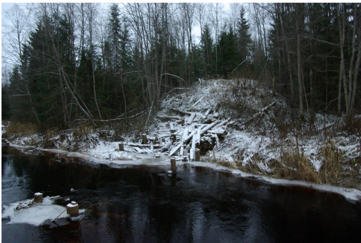
Фото 18. Опоры старого железнодорожного моста через р. Тутоку.
