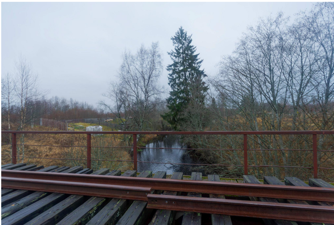
Фото 56. Мост через р.Перовка
