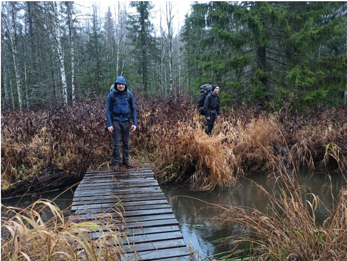
Фото 13. Мост через р.Смородинка.
