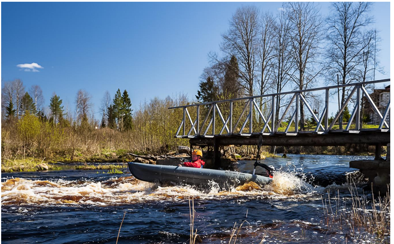
Фото 4.5. Б2 в пороге под мостом
